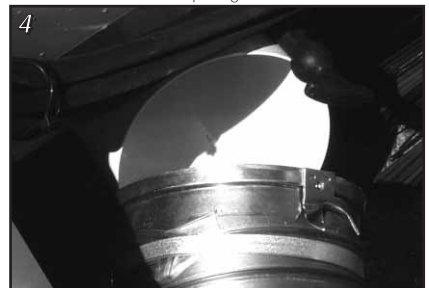
Aansluiting van de opvangbuis
