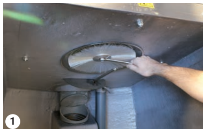
1 Демонтиране на въртящия се филтър
