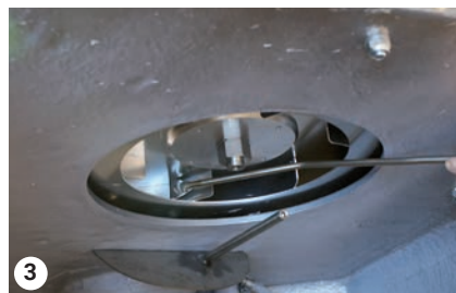
3 Почистване на турбината
